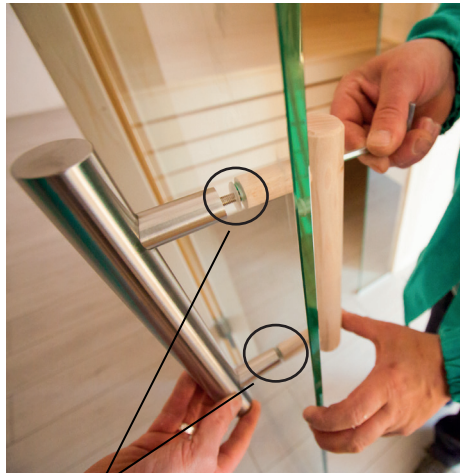
Kunststoff Beilagscheibe bei Niro-Griff beilegen
