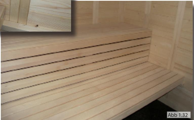
Auflageleiste unterhalb Querbank montieren - Schrauben 4 x 70 mm
